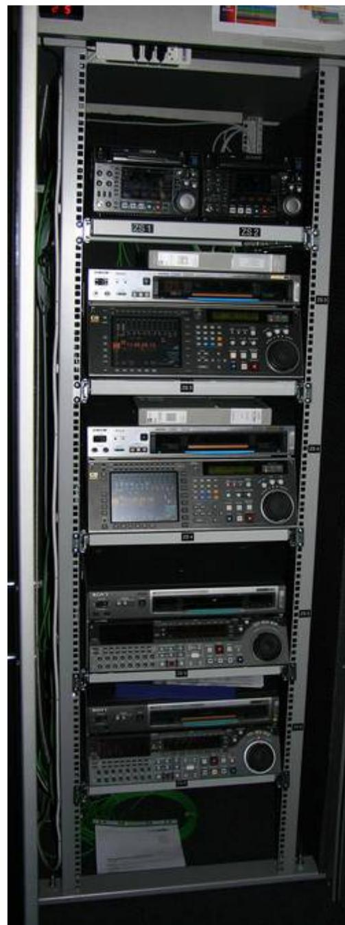
Der Quality & Ingest Room ist als einziger Raum in der Sendezentrums-Installation noch mit Bandmaschinen bestückt.
